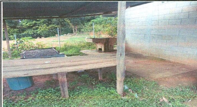
Foto 2: Mejoramiento area de cocina
